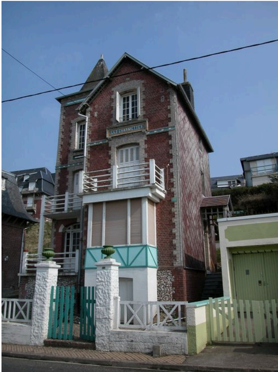
Vue de trois-quarts sur élévations antérieure et latérale droite.
