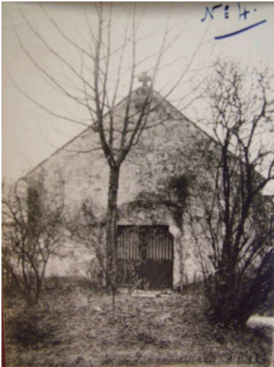
Vue ancienne de l'extérieur de la chapelle (AD Aisne : 15 R 1336).
