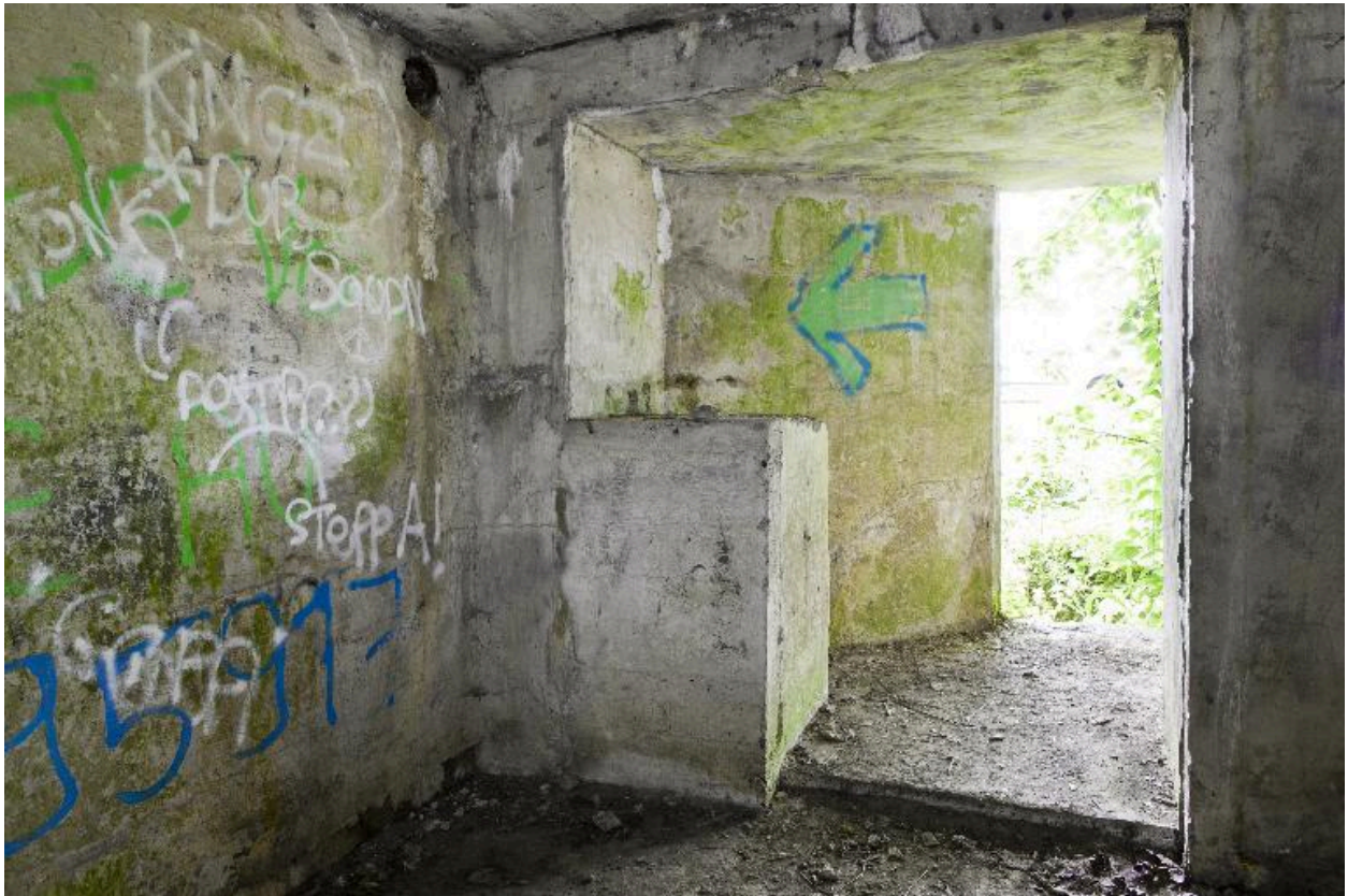
Salle nord. Vue vers l'entrée.
