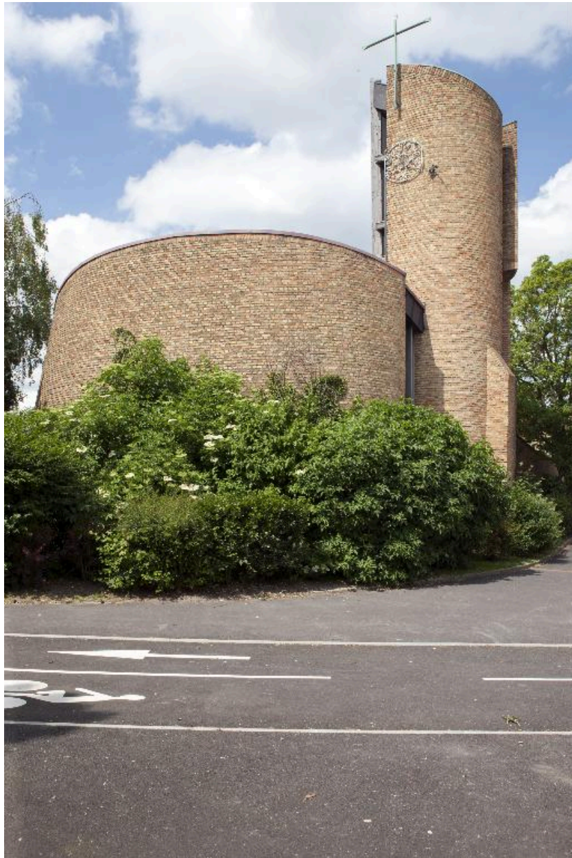
Élévation postérieure de l'église.
