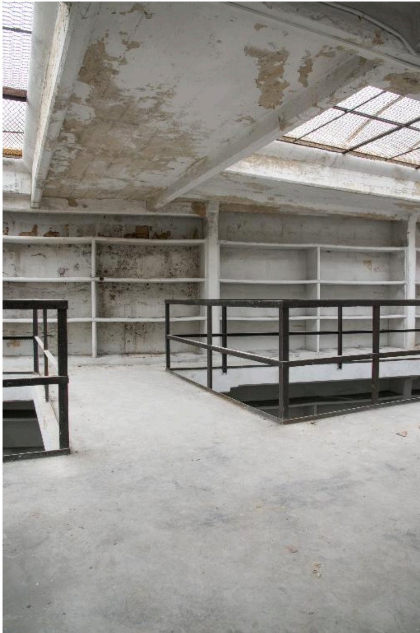
Bâtiment du dépôt, troisième étage : vue du palier transversal au vaisseau 4.
