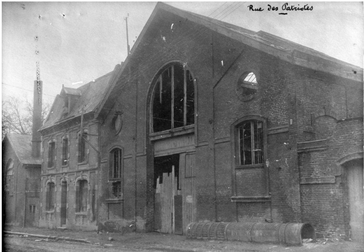
Ateliers et logement patronal, rue des Patriotes, 1919 (AD Aisne).
