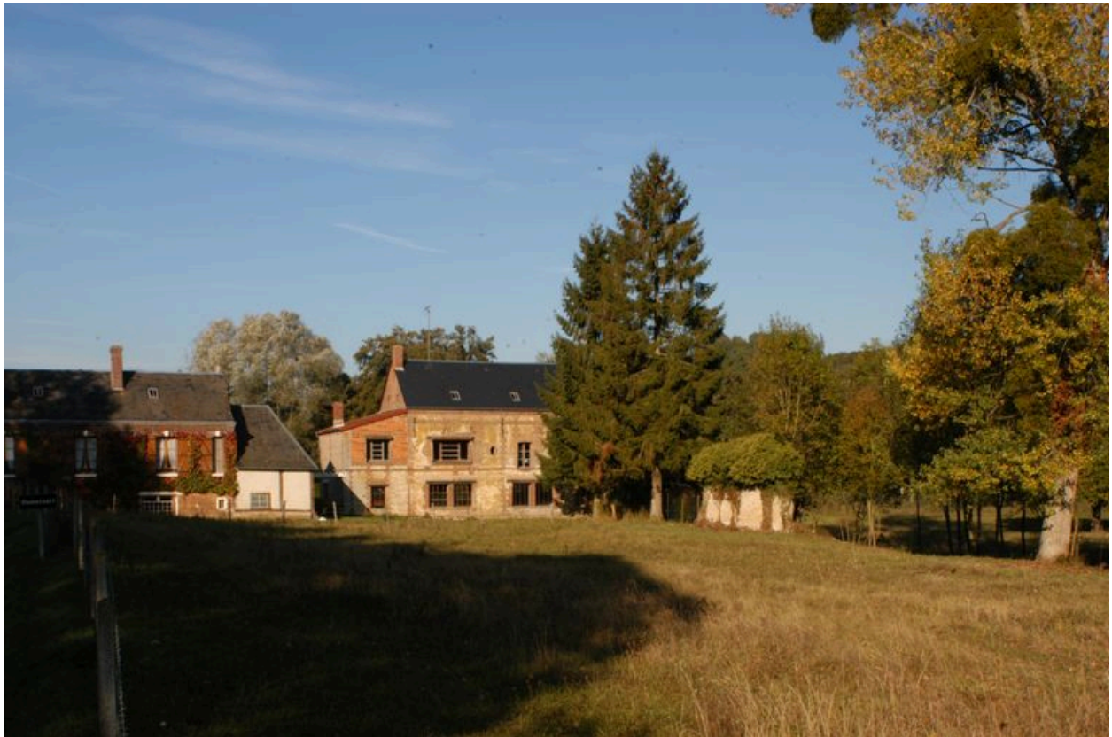
Vue d'ensemble de l'atelier de fabrication, façade est.
