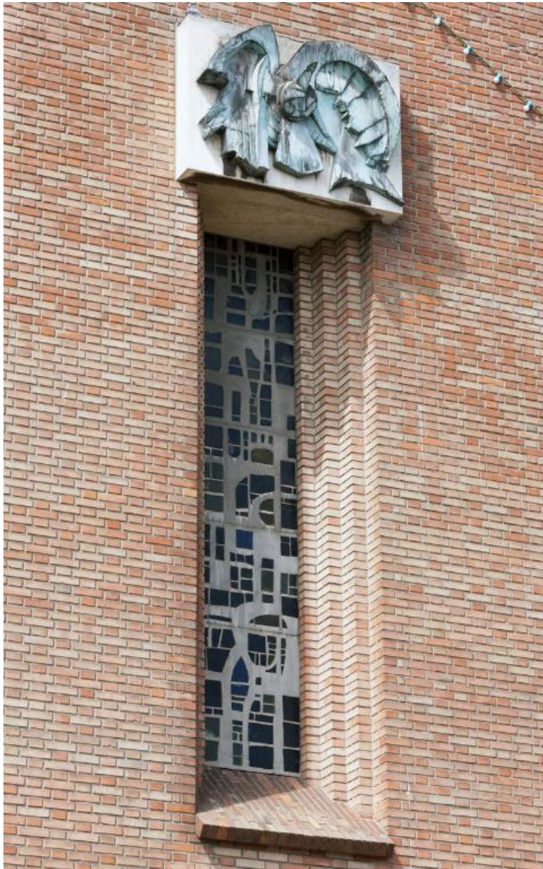
Vue de la verrière de la façade antérieure.
