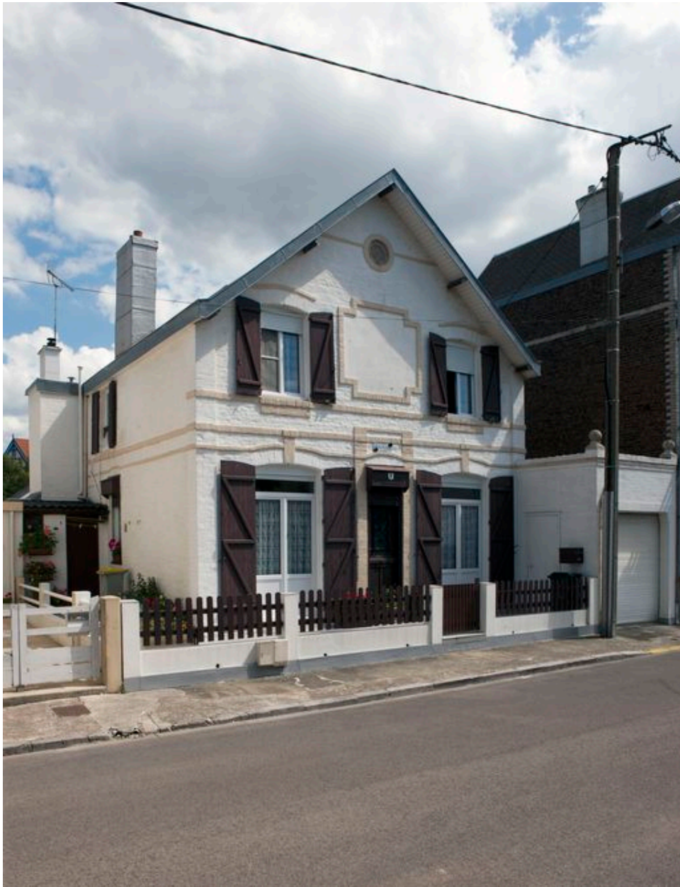
Façade du 3 rue Chambon.
