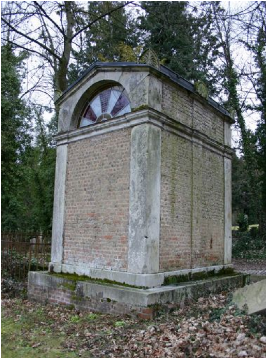
Vue générale postérieure.
