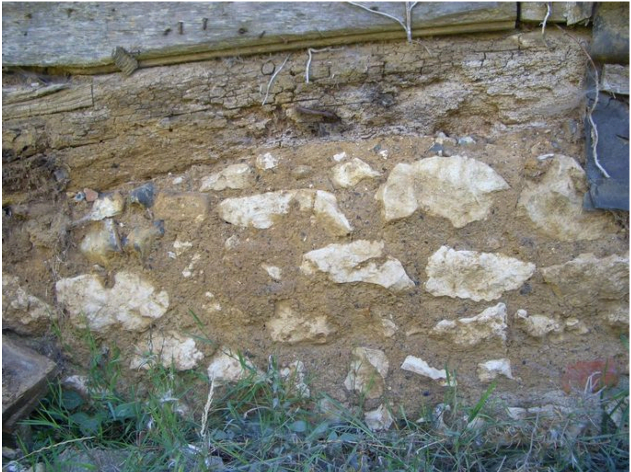
Vue du solin de la grange composé de moellons de calcaire et silex.
