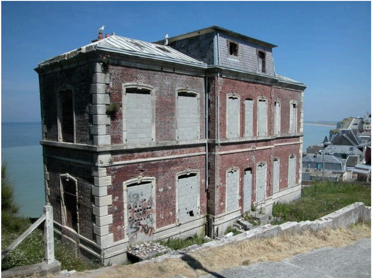
Vue d'ensemble, façade postérieure.
