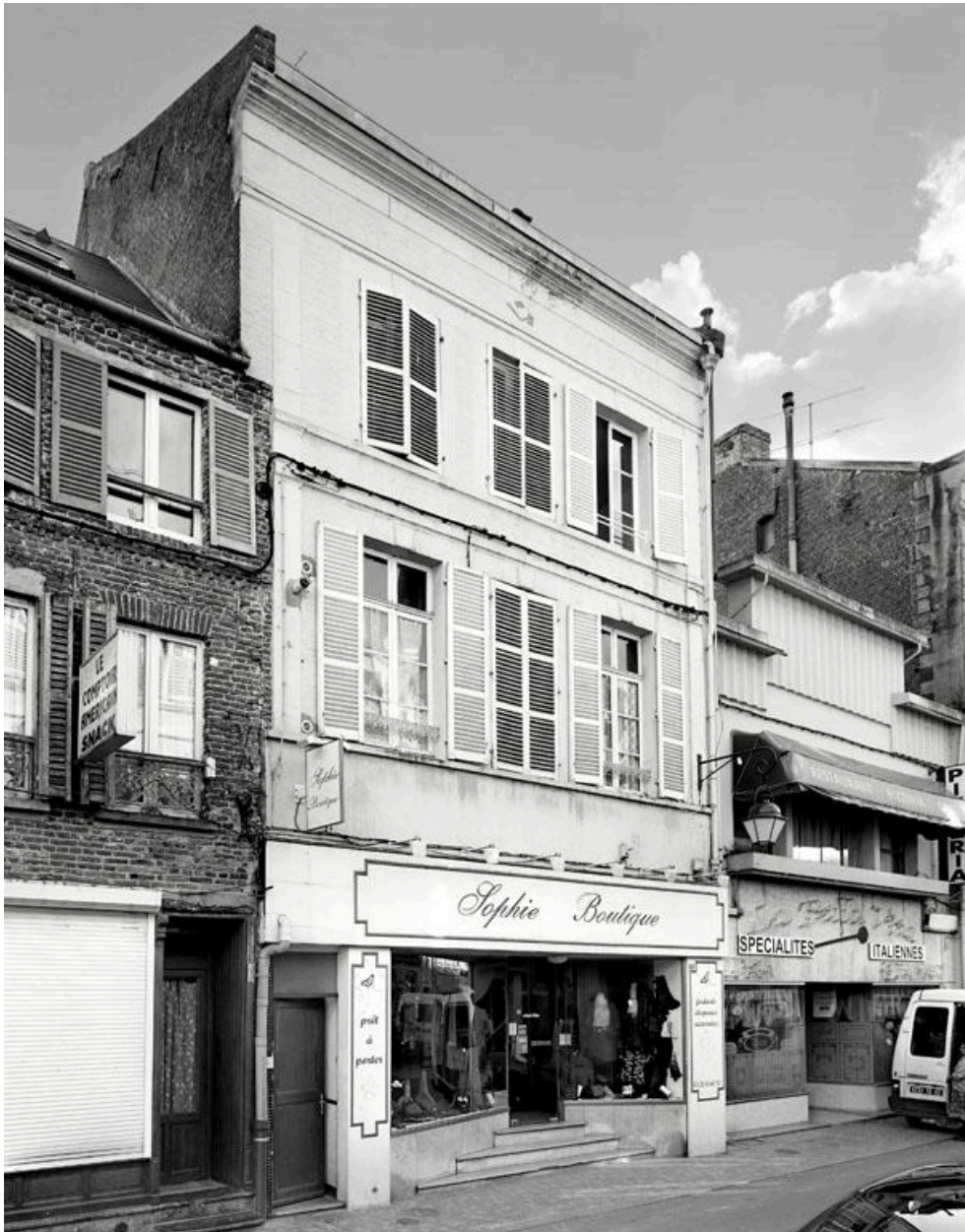
Vue de la façade sur rue.
