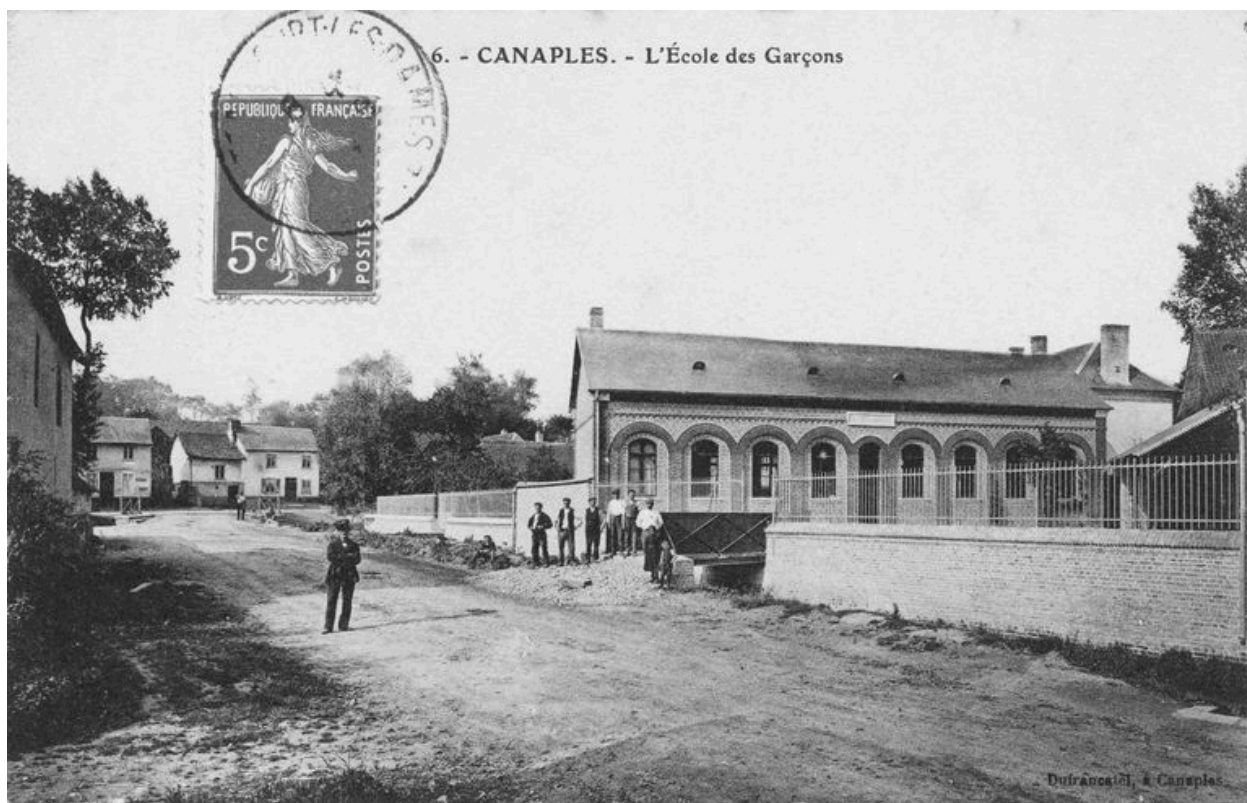
Vue arrière du bâtiment principal et de la cour des garçons, avant 1914 (coll. part.).
