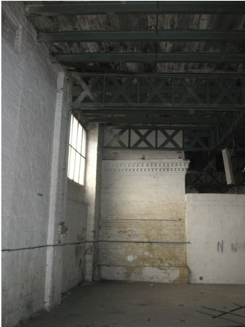
Base carrée de la cheminée au rez-de-chaussée.
