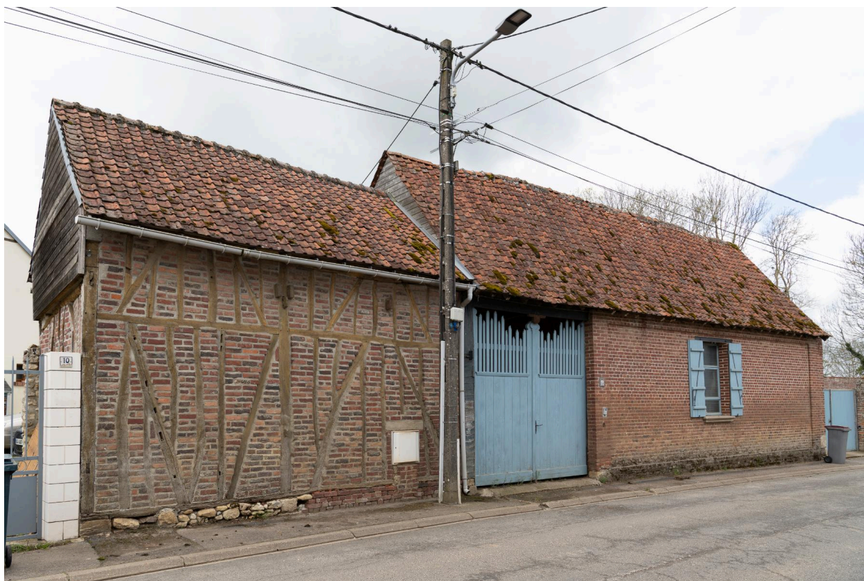
Ancienne grange sur rue avec entrée charretière, n°8 de la Grande Rue, vue prise depuis l'est.
