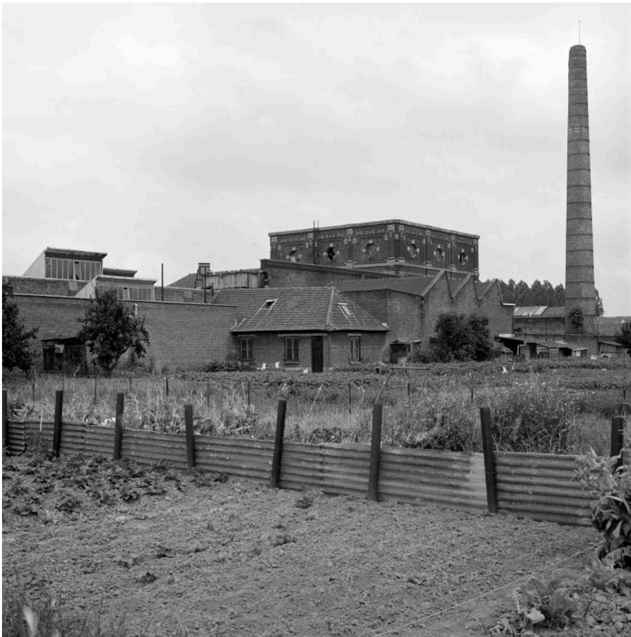
Vue générale vers l'ouest depuis les jardins ouvriers.
