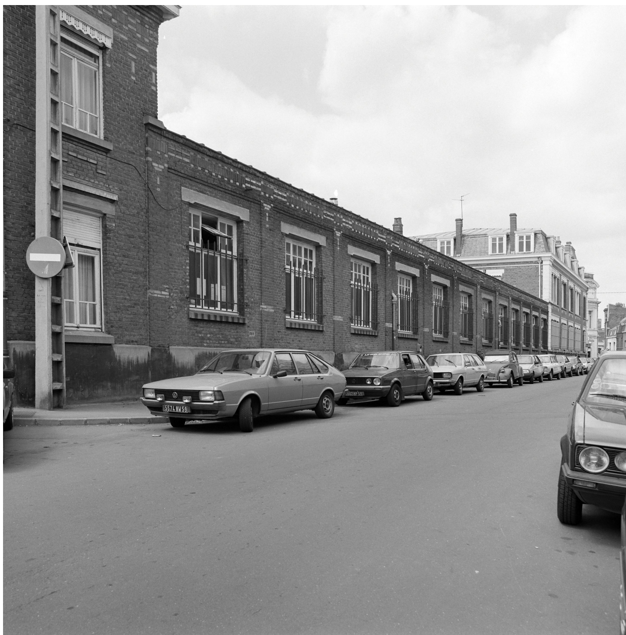
Élévation rue Jules-Ferry. Atelier de fabrication.
