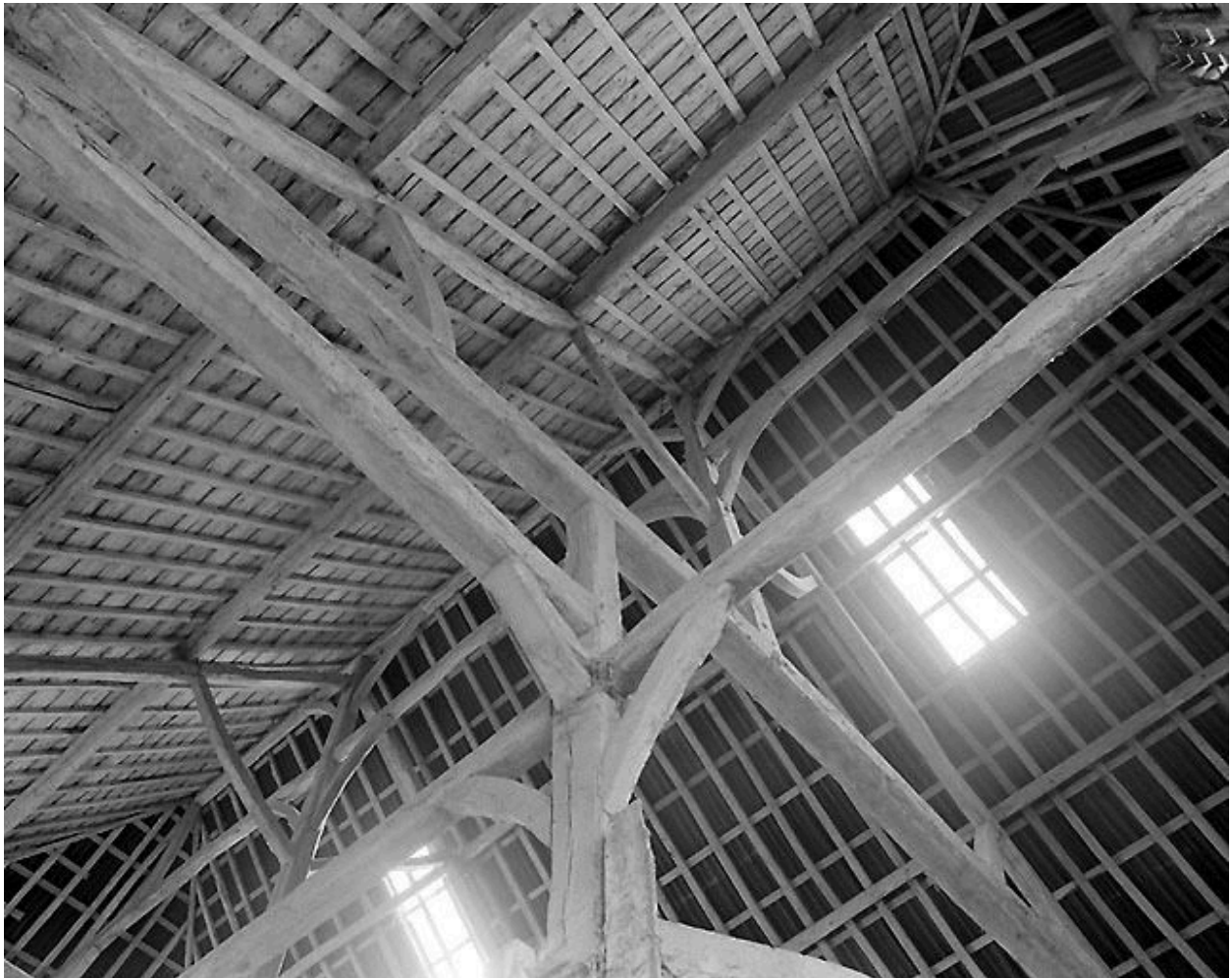
Grange : détail de la charpente et des faux-entrails.
