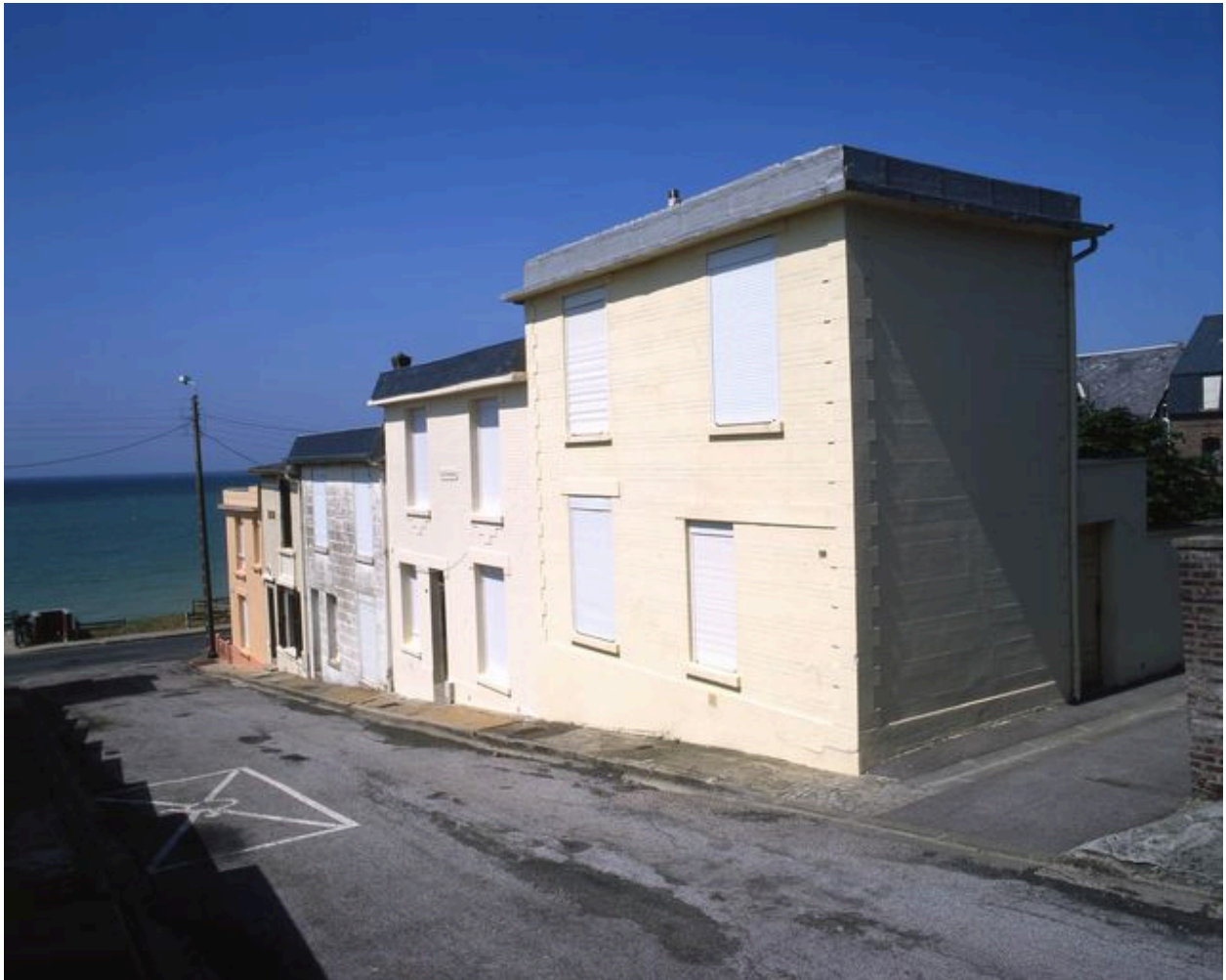
Vue d'ensemble depuis la rue Continental.
