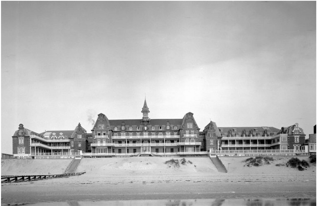
Bâtiments constitutifs de l'établissement primitif, élévations donnant sur la plage, vue d'ensemble prise de face.
