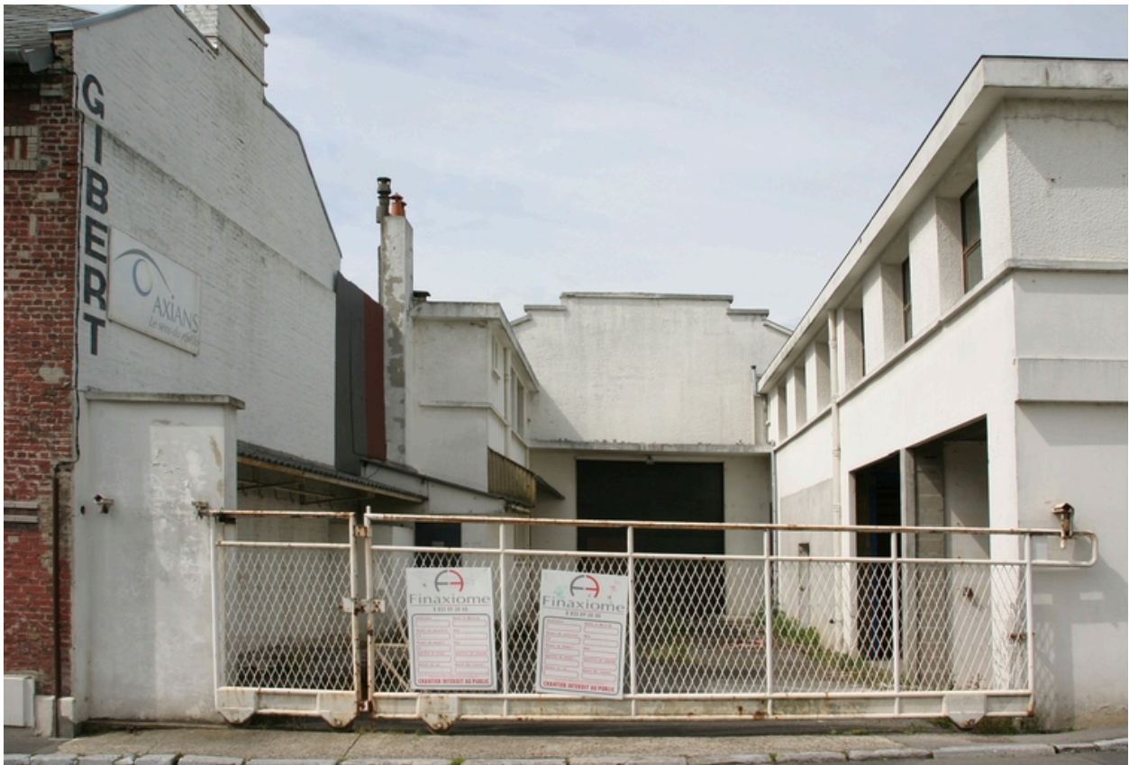
Entrée des bureaux et ateliers de 1959, rue des Patriotes.
