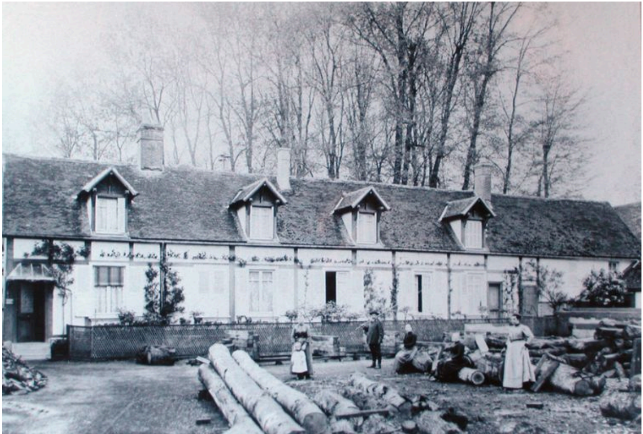
L'aire de séchage des grumes dans la cour, devant le logement patronal.
