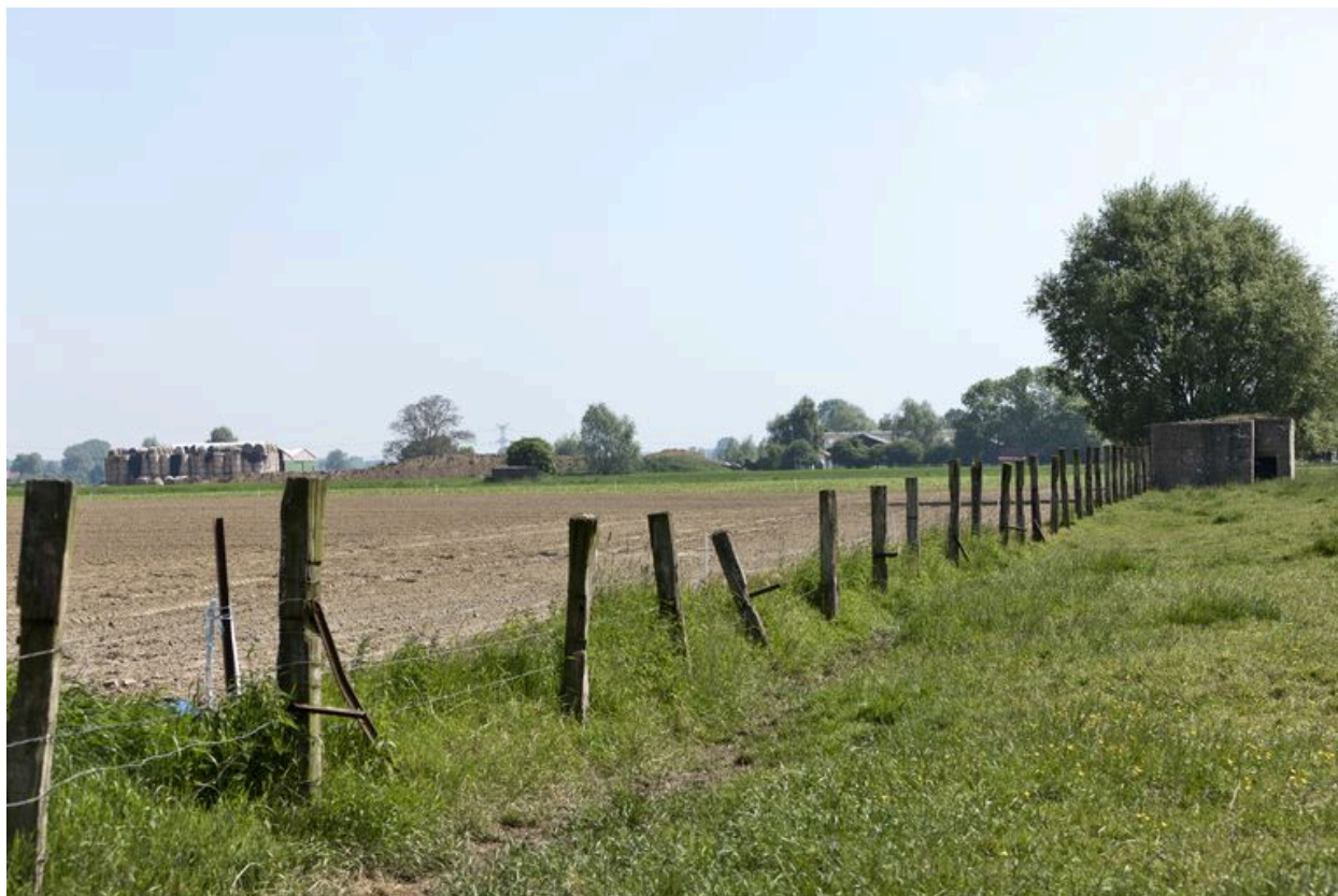
Vue générale vers le nord-est
