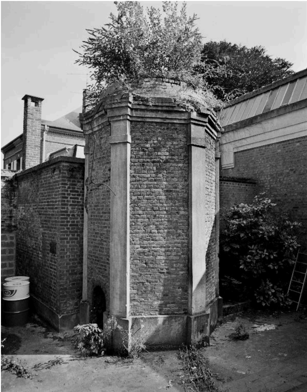
Cheminée d'usine, socle.
