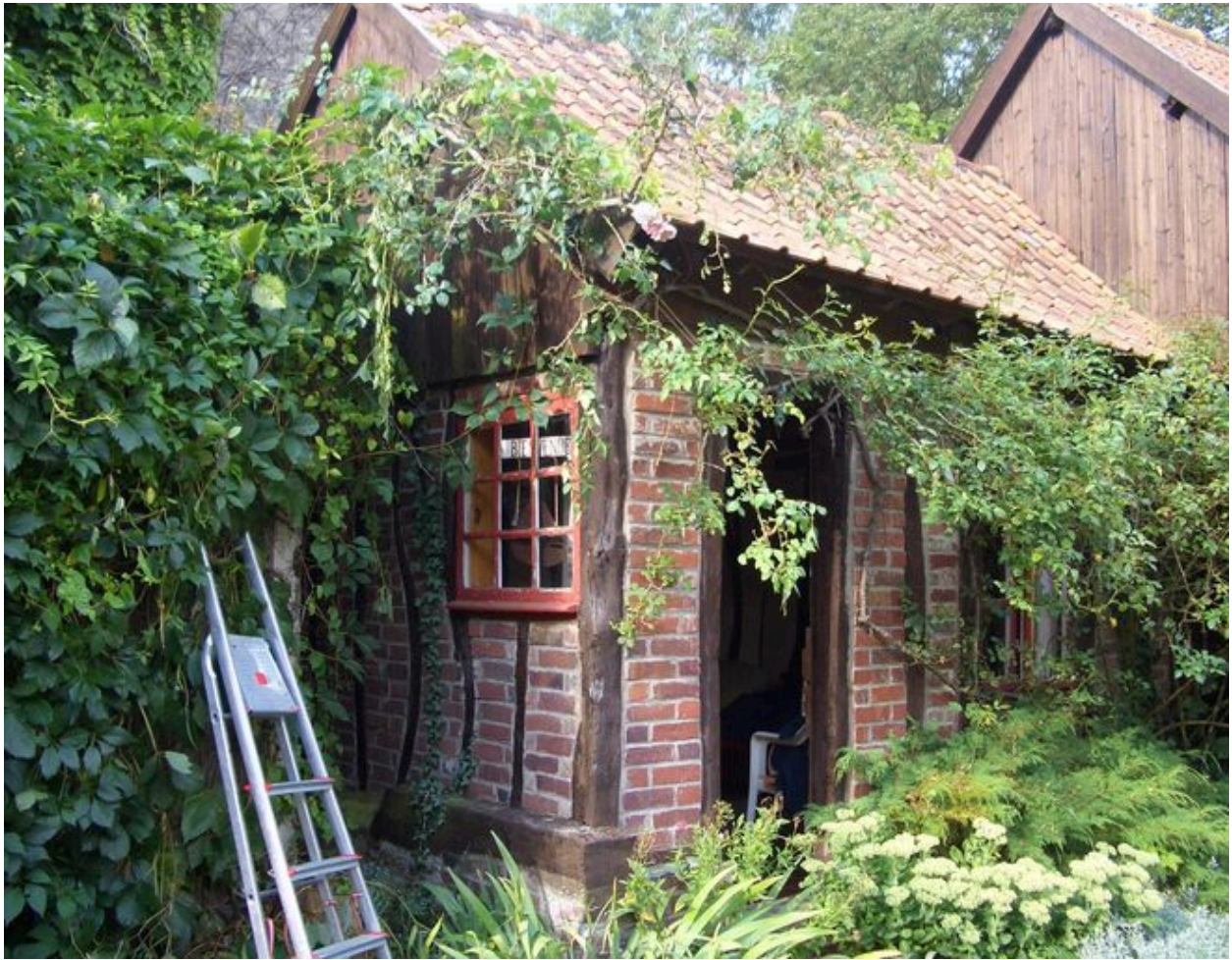
Vue d'une ancienne dépendance agricole.
