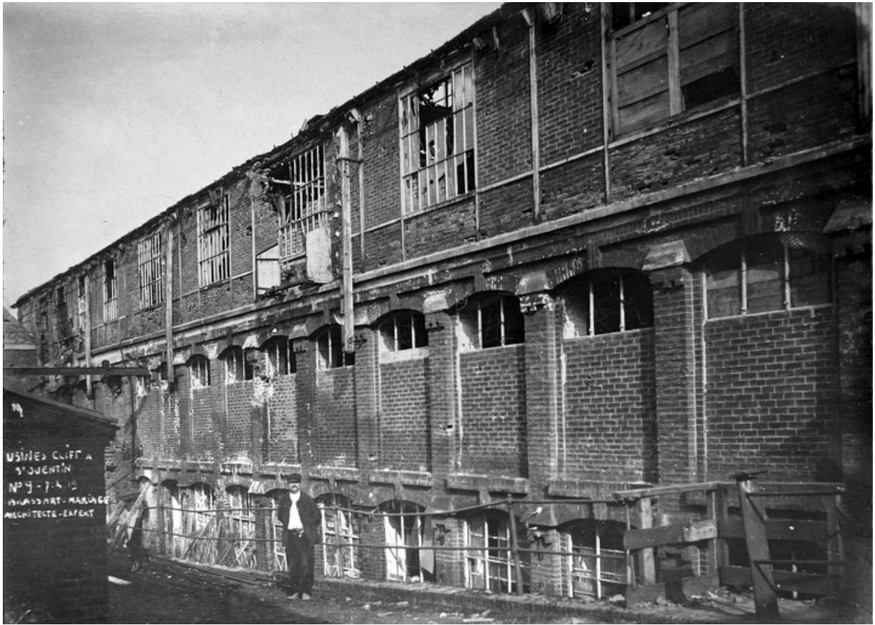
Façade ouest de l'atelier d'apprêt et bordage, par Brassart-Mariage, mai 1919 (AD Aisne).
