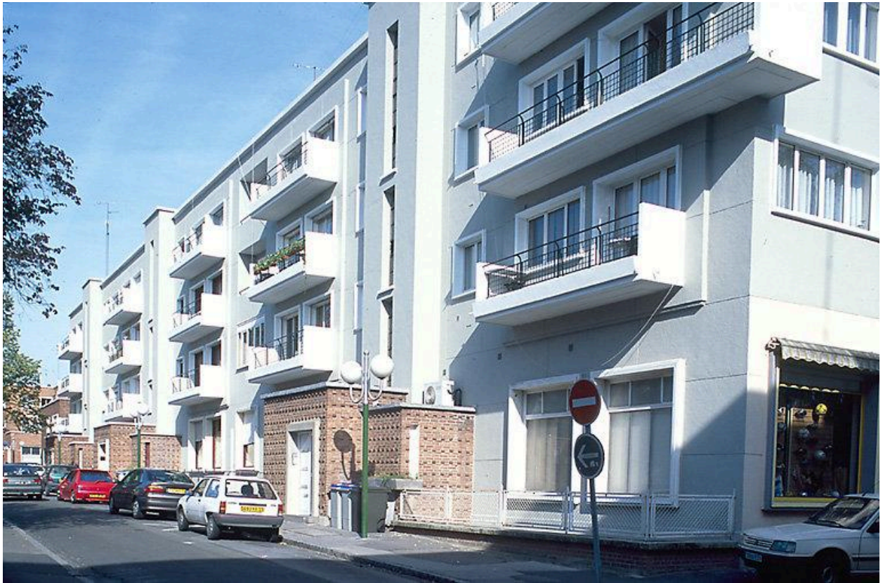
Vue générale de l'élévation sur la place de la Concorde.
