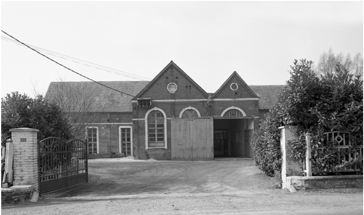
Entrée de l'usine.
