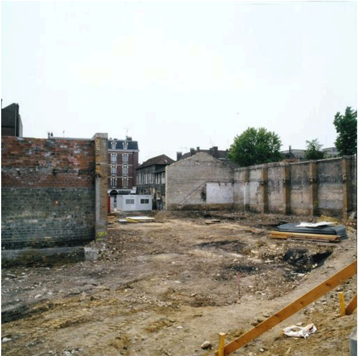
Démolition des bâtiments en 2007.
