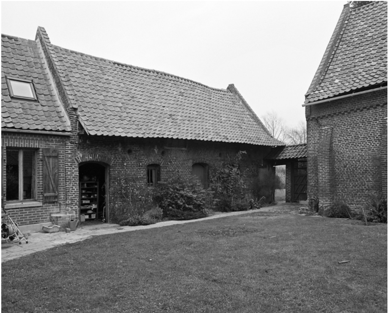
Élévation antérieure de l'étable-écurie sur cour.
