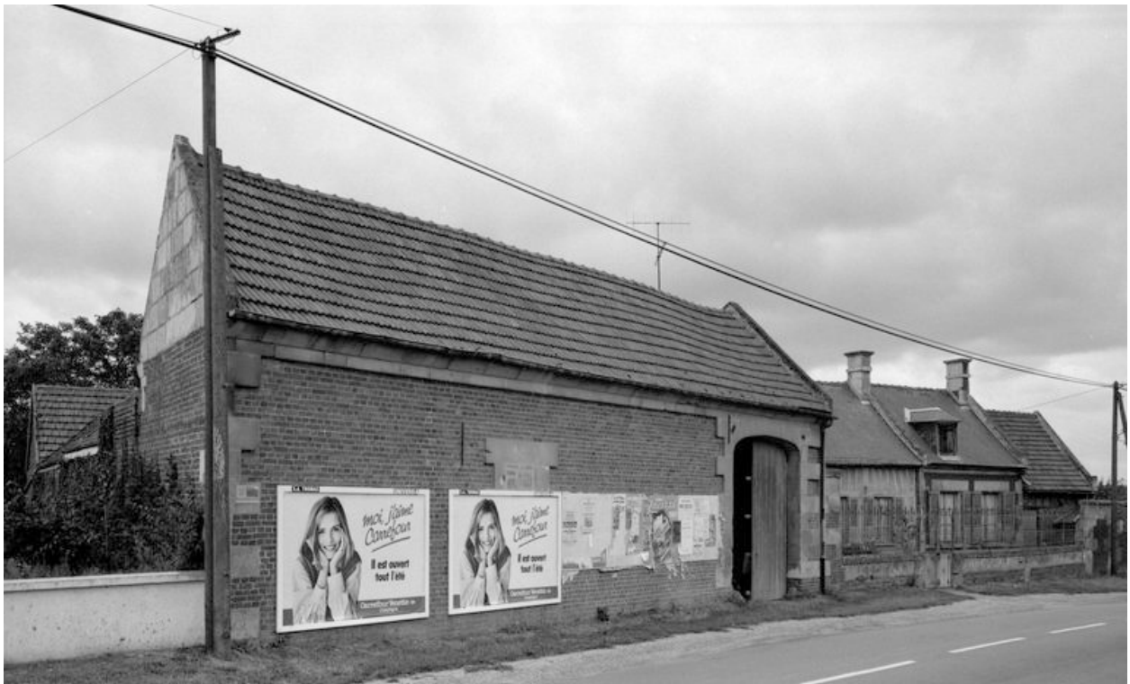
Grange. Elévation sur rue.
