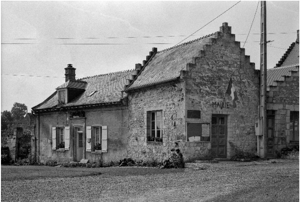
Vue de la mairie actuelle, depuis le nord.
