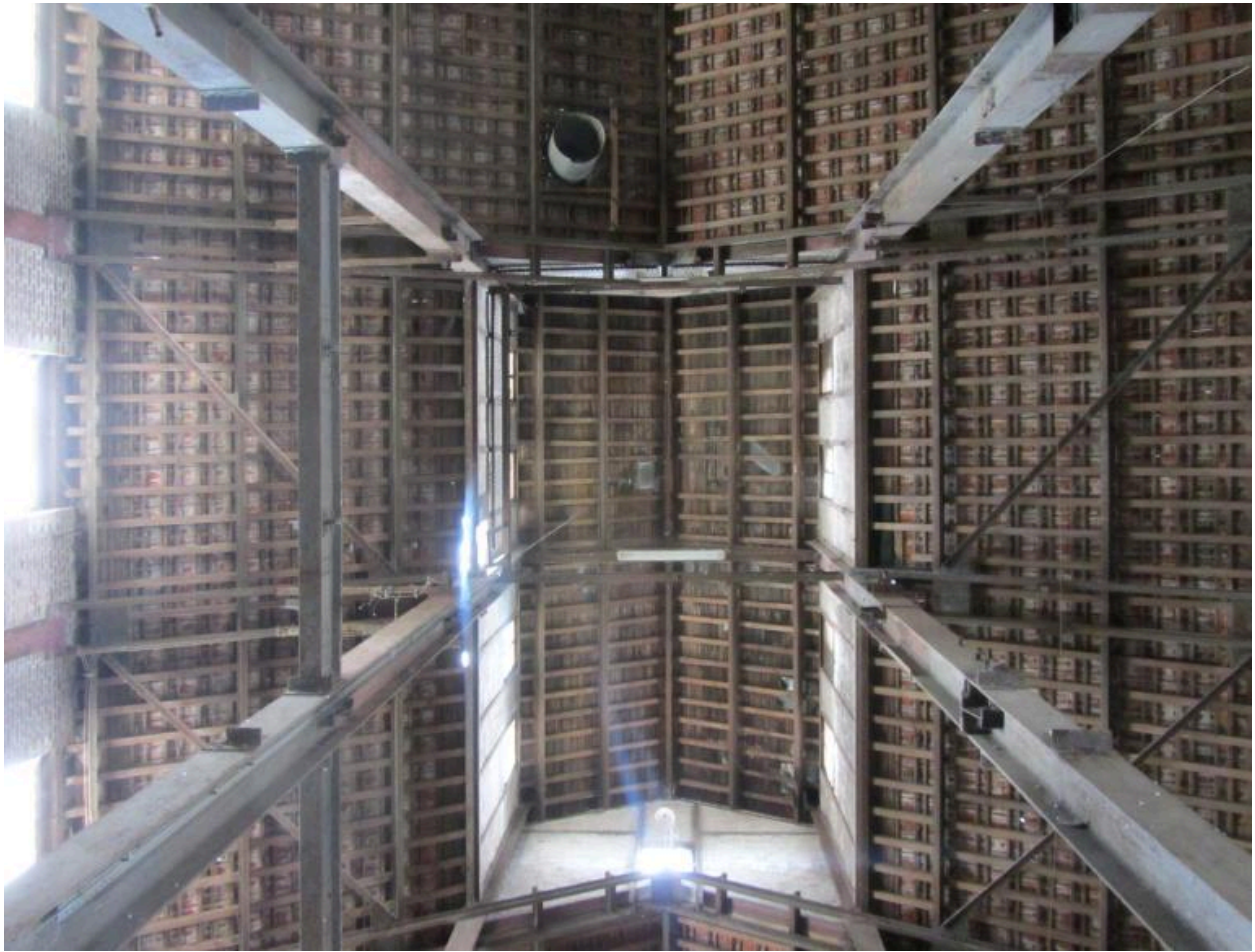
Vue intérieure de la charpente métallique de l'atelier principal de la râperie.
