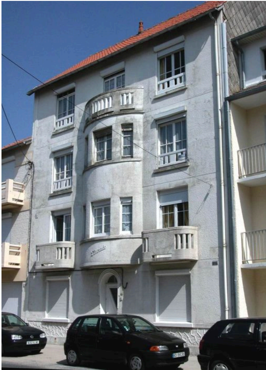
Immeuble à logements (L'Emeraude, 59 Bd Intérieur).
