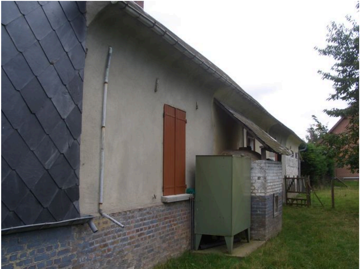
Vue postérieure du logis avec corniche arrondie et four à pain abritant une cave.
