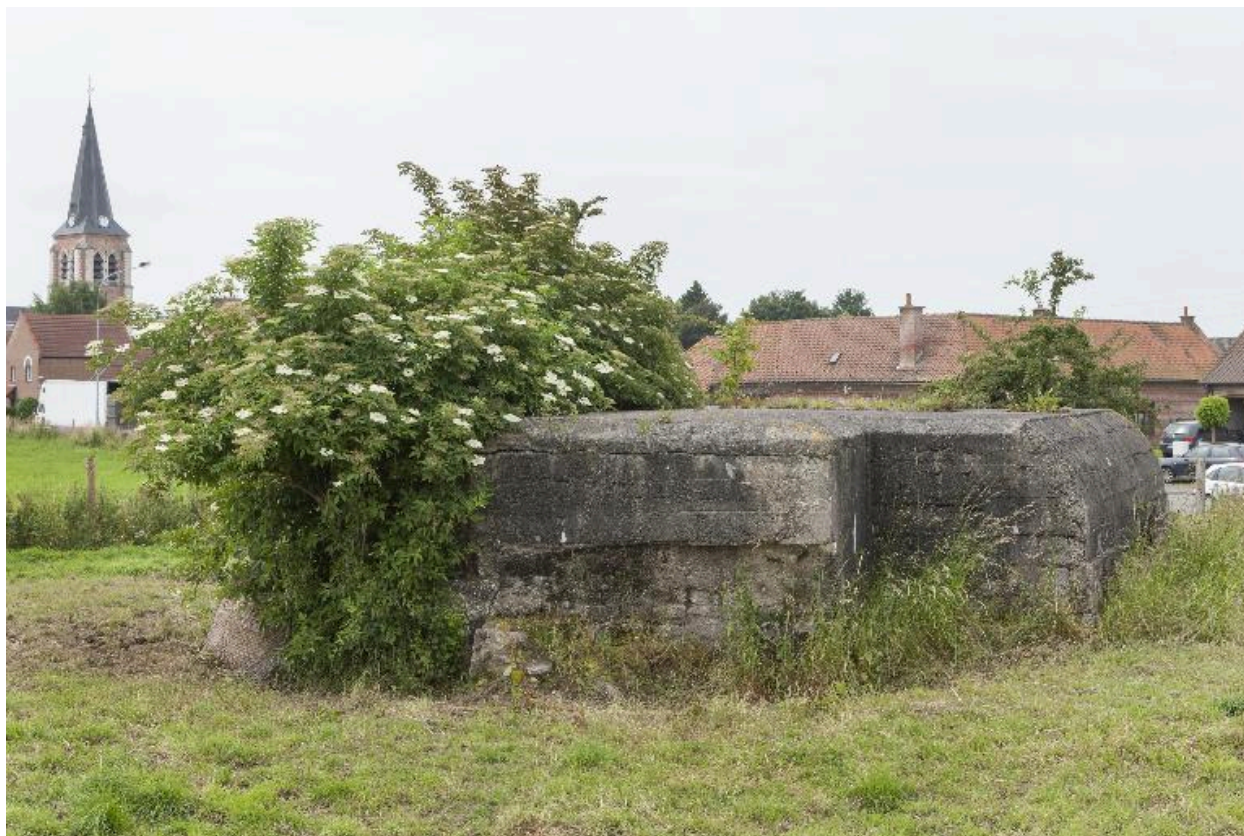
Casemate a, vers le sud-ouest
