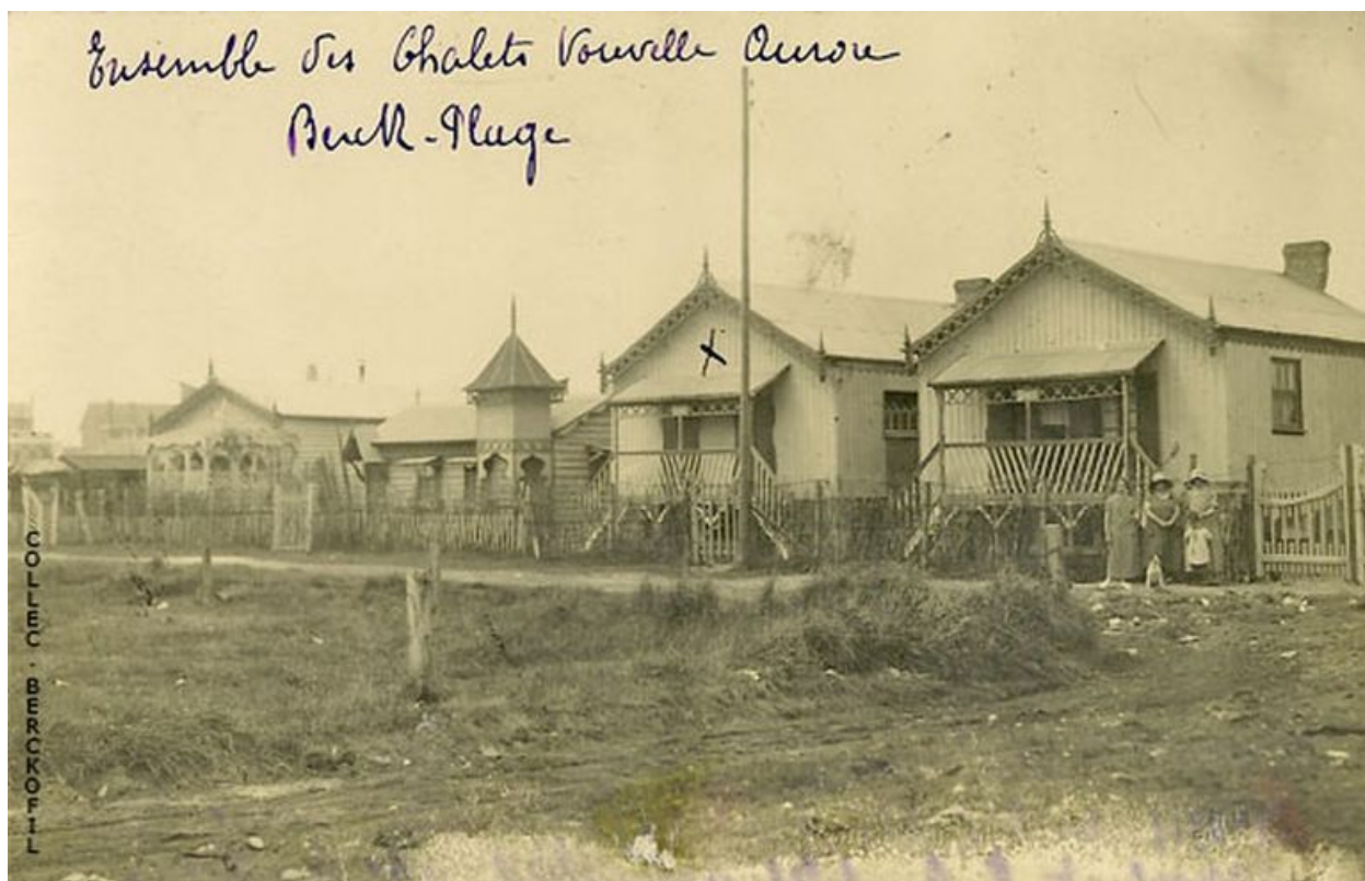
Chalets Nouvelle Aurore, constructions en matériaux légers.
