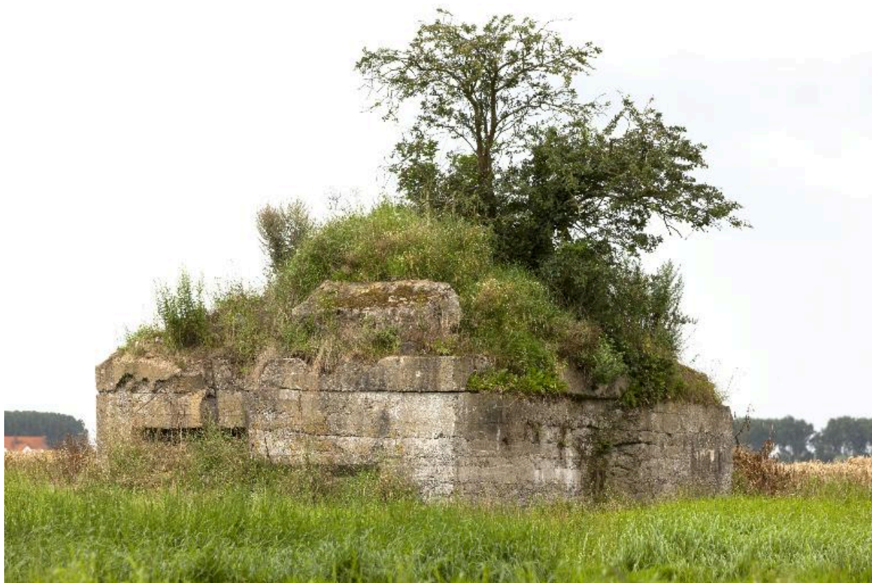
Vue générale, vers le sud-ouest
