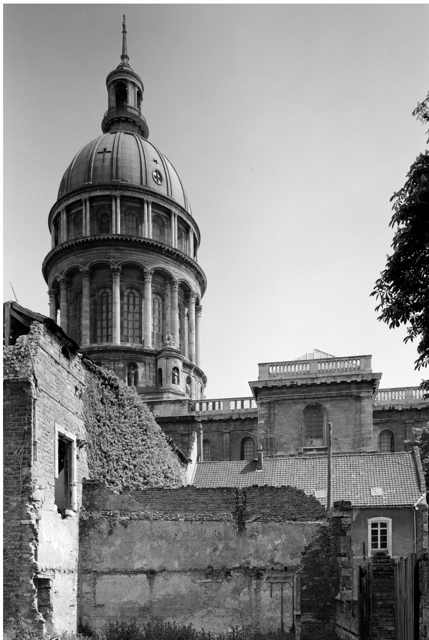
Bâtiment G, conciergerie, vue d'angle.
