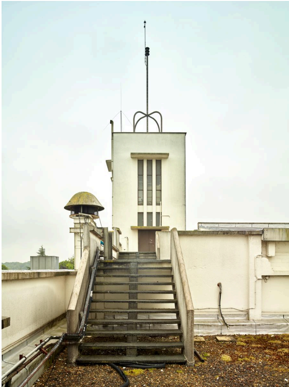
Tour surmontant l'atelier de fabrication (H) depuis le couverture du bâtiment de conditionnement (AH), vers le sud.
