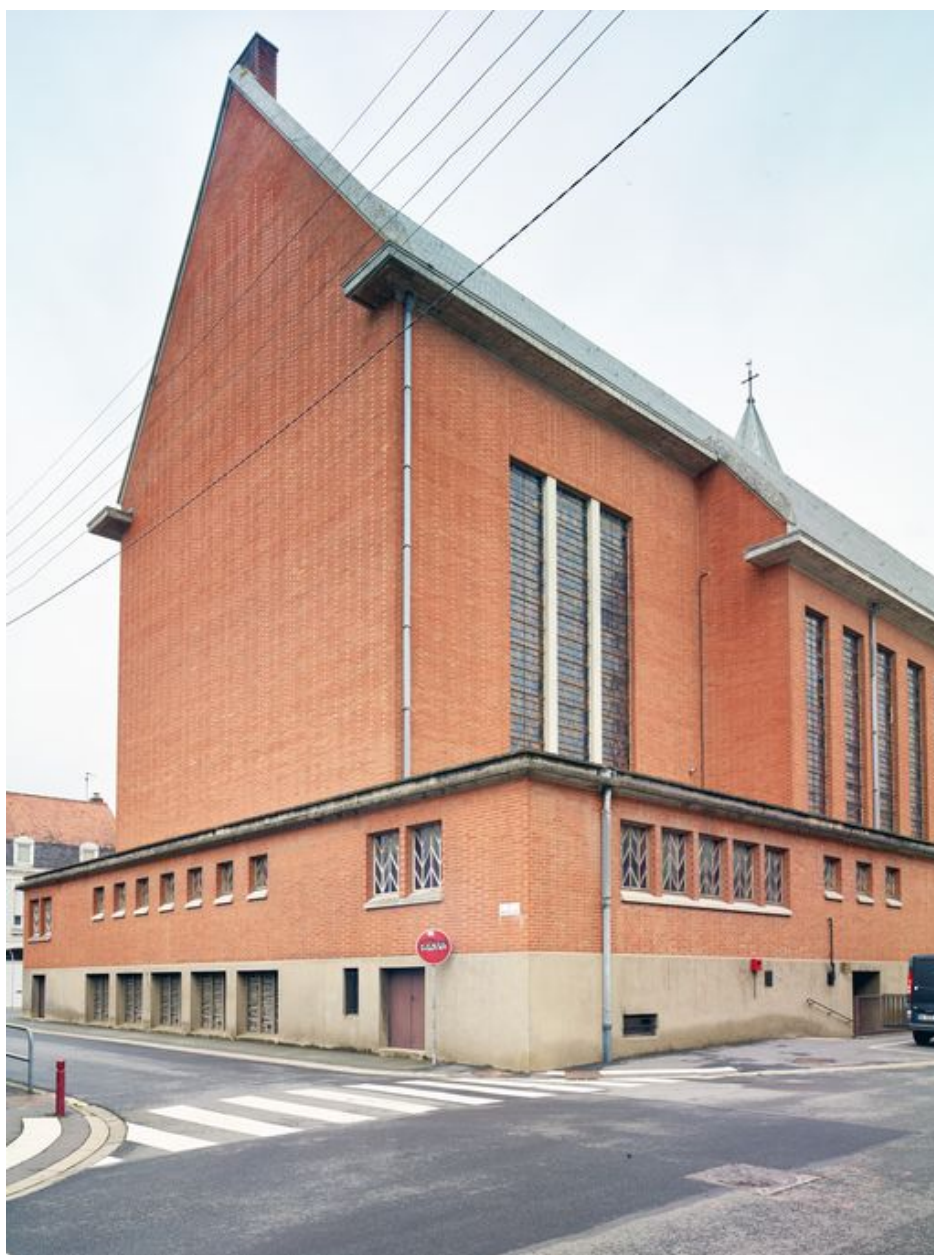
Élévation postérieure de l'église.
