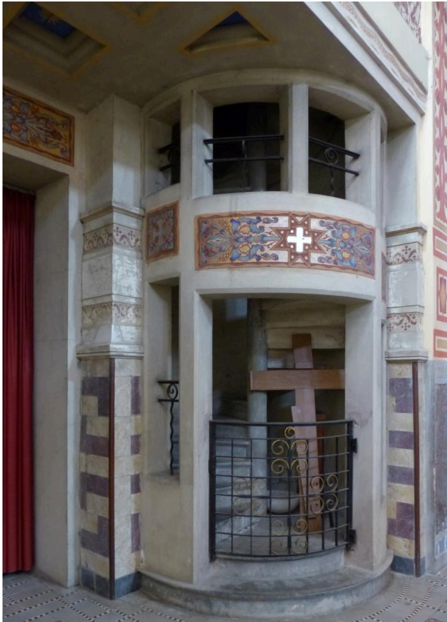
Vue de l'escalier d'accès à l'étage de la chapelle axiale.
