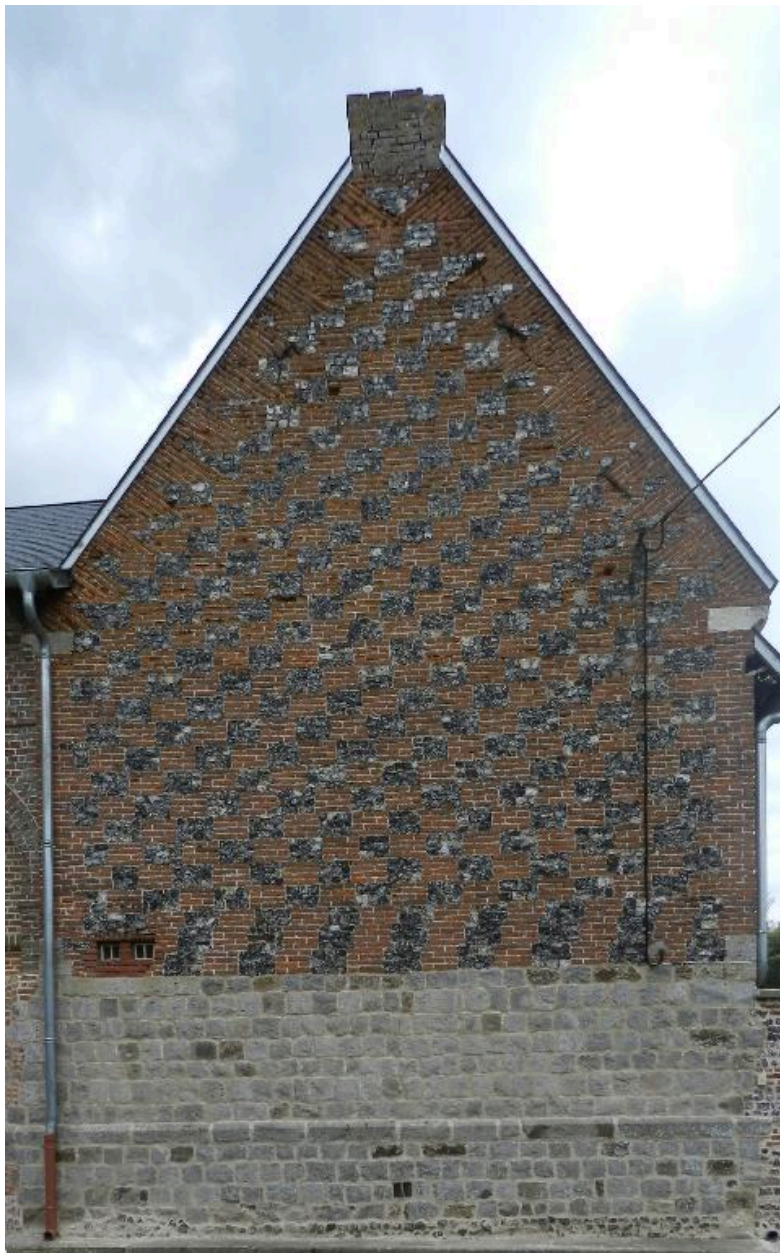
Le mur-pignon du manoir depuis la rue.
