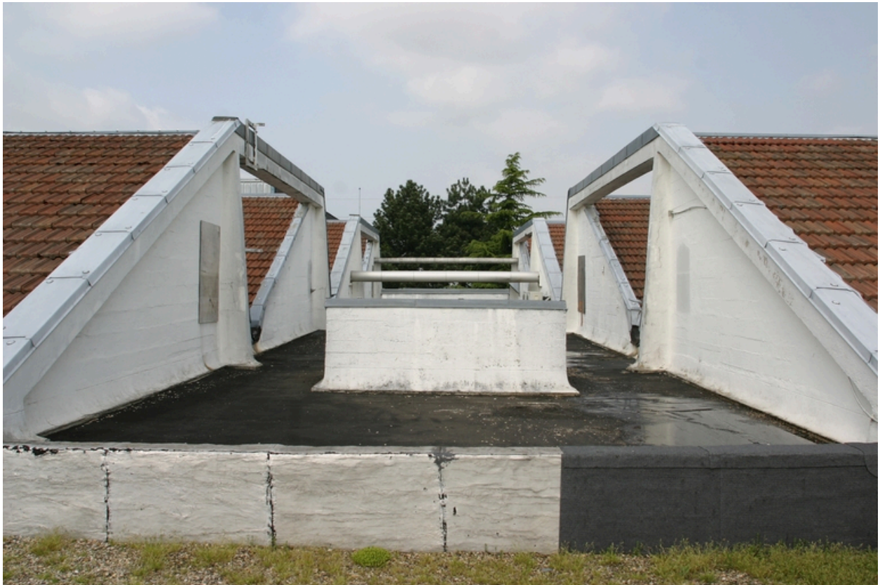
Détail des sheds des ateliers de 1929.
