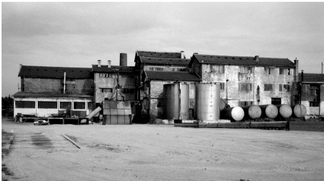
Vue générale : flanc ouest.
