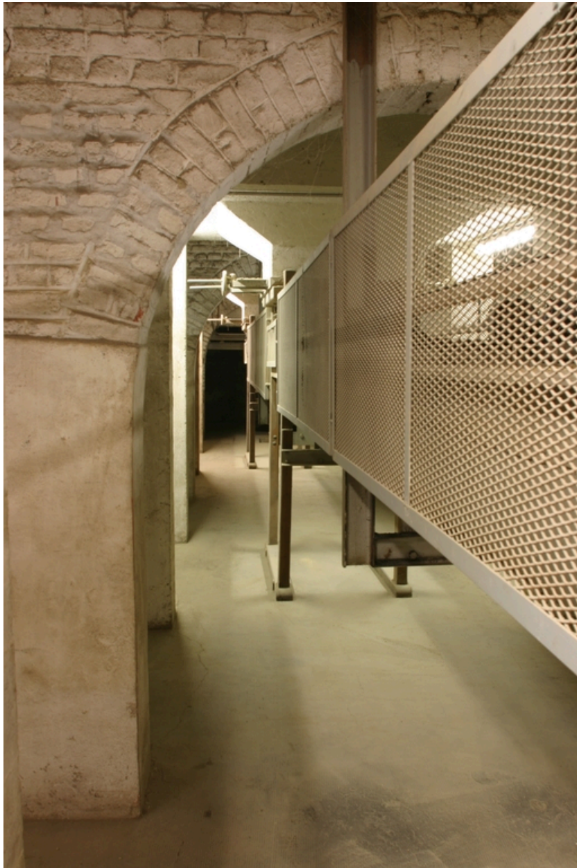
Base des cellules du silo à blé.
