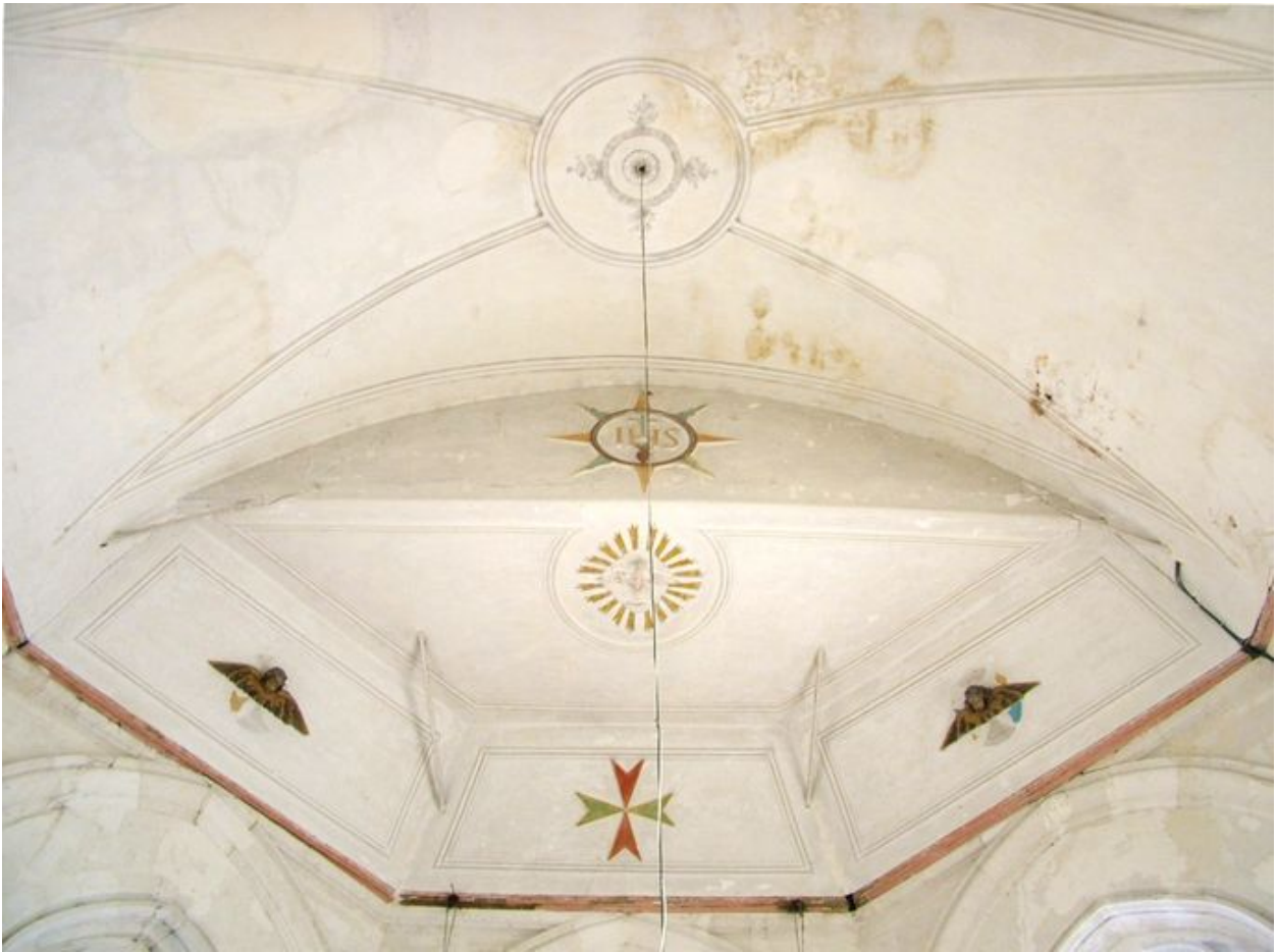
Fausse-voûte du chœur, milieu du 18e siècle.
