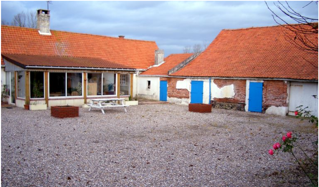
Vue du logis et d'une partie de la grange.
