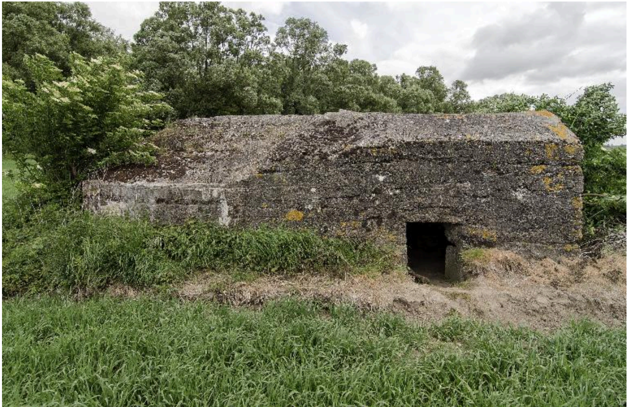
Vue latérale vers le nord-est. Entrée
